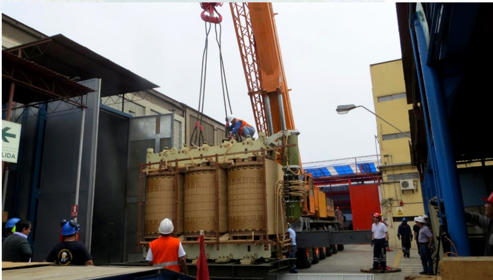
MONTAJE DE EQUIPOS EN EL SECTOR METAL MECÁNICO
