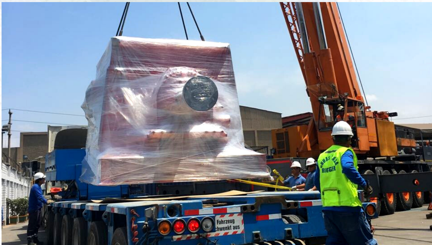
LEVANTAMIENTO DE EQUIPOS DE GRAN TONELAJE CON TRANSPORTE ESPECIAL
