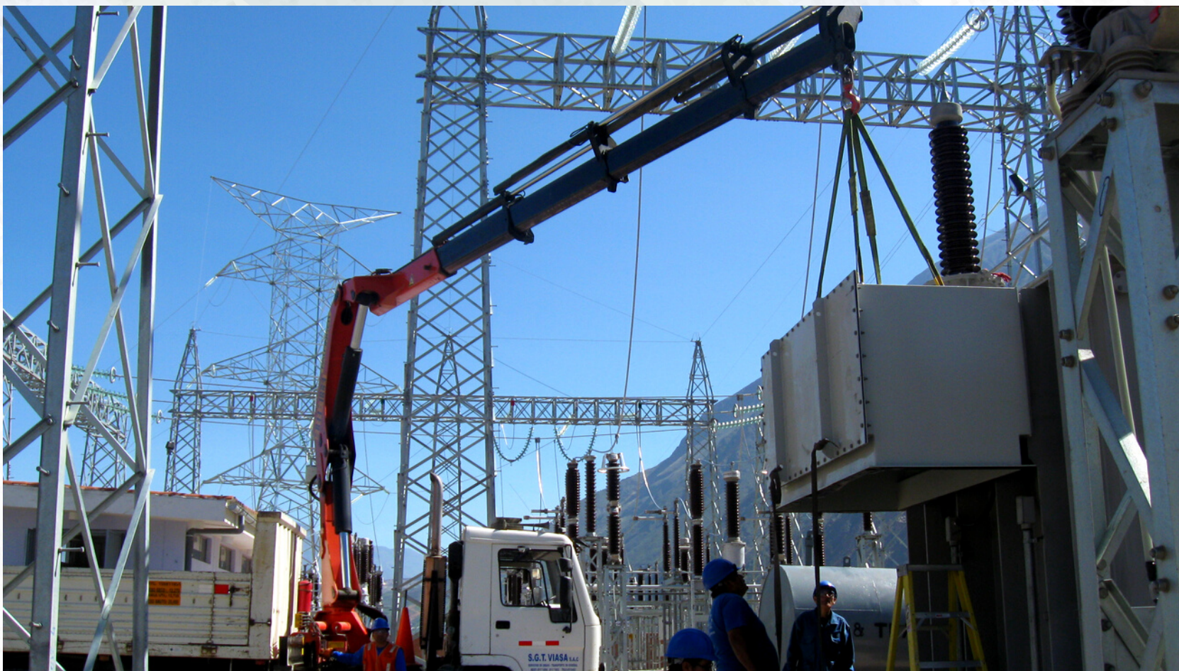
IZAJE Y MANIOBRA DE EQUIPOS DE ENERGÍA
