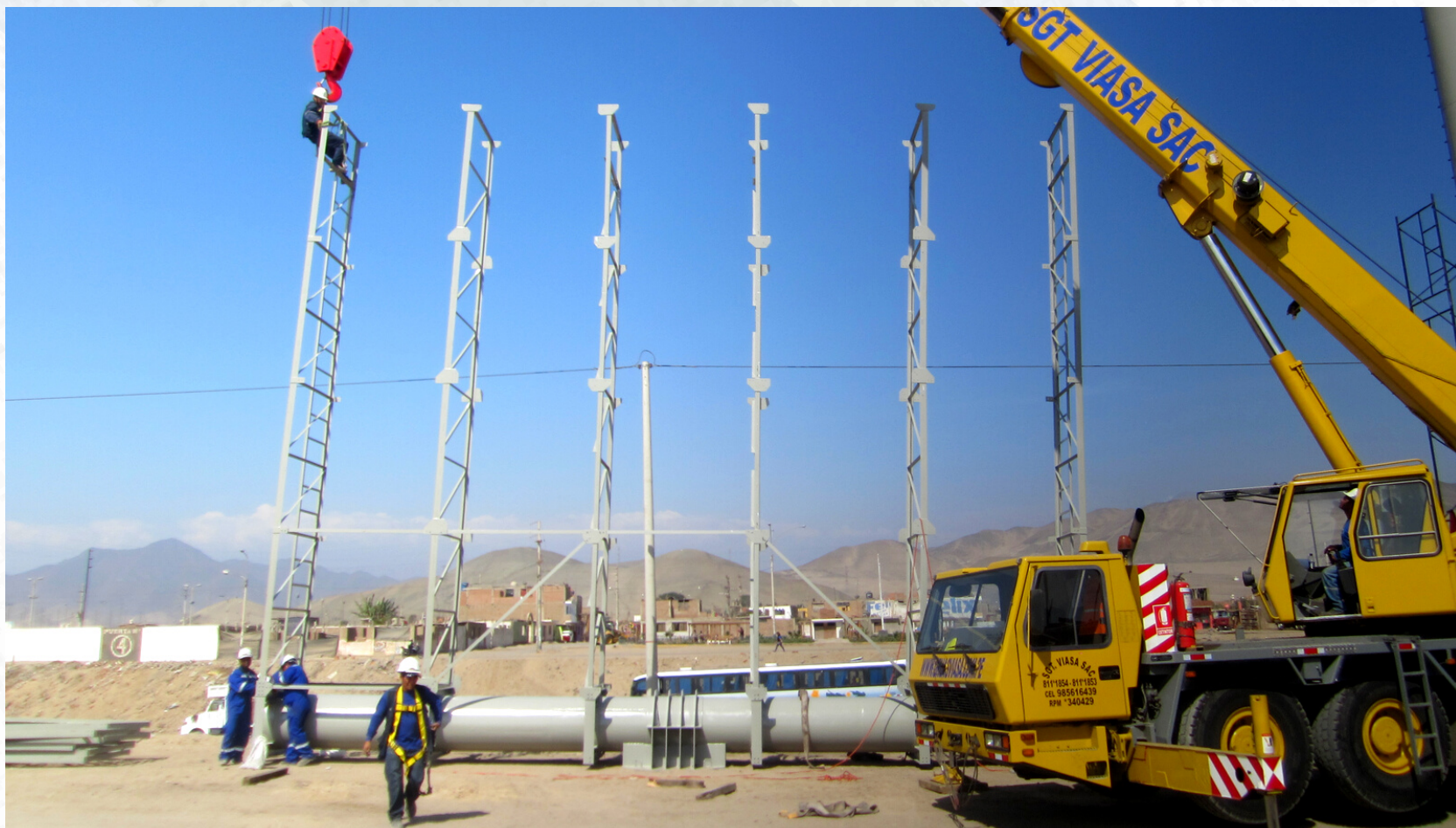
MONTAJE Y DESMONTAJE DE ESTRUCTURAS
