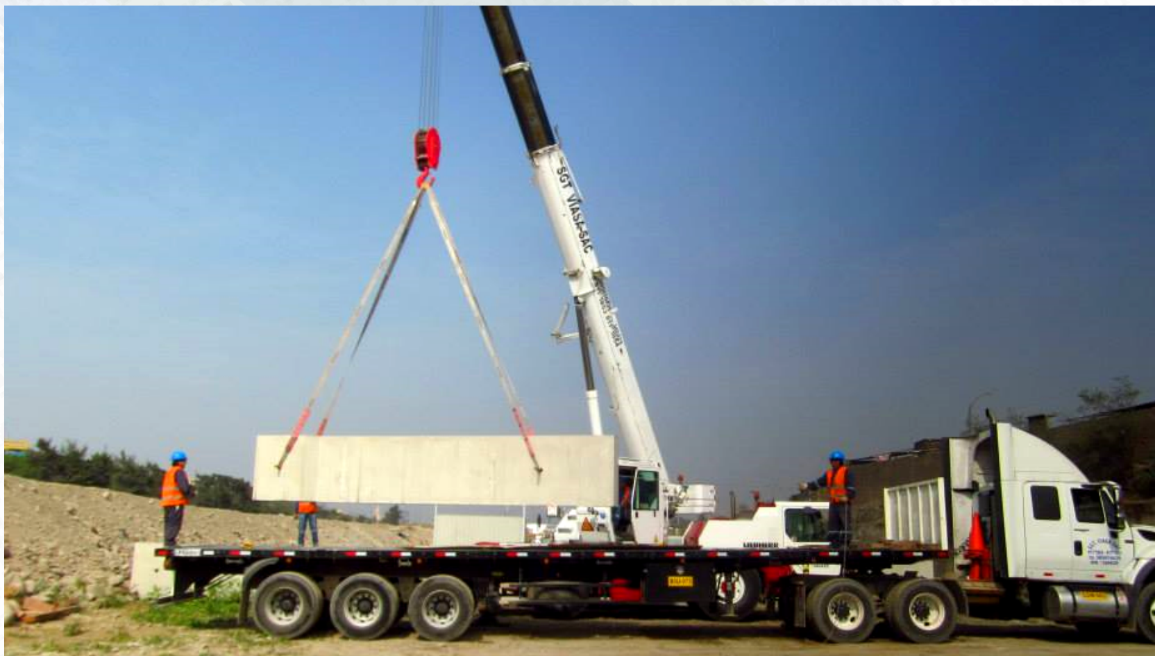
TRANSPORTE ESPECIAL DE ELEMENTOS DE CONSTRUCCIÓN
