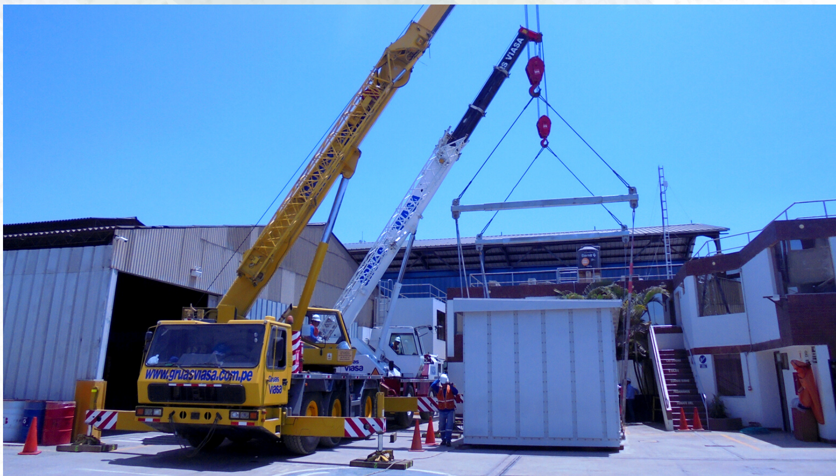
MONTAJES ESPECIALES EN ESPACIOS REDUCIDOS
