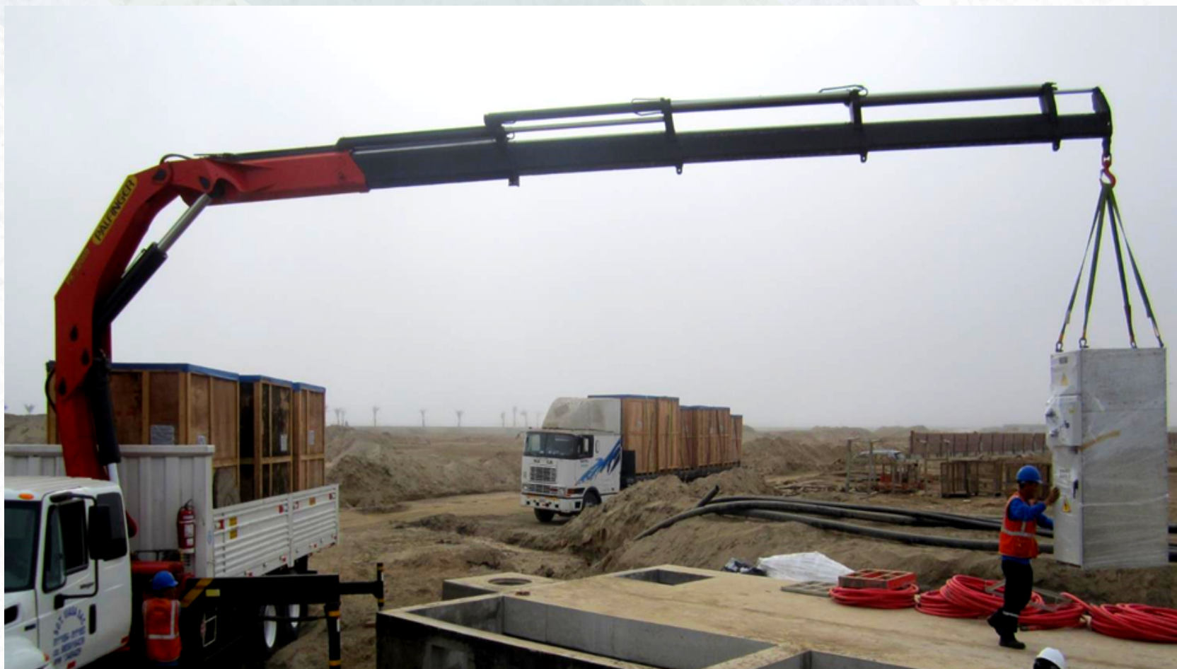
SERVICIOS INTEGRADOS DE GRÚA Y TRANSPORTE
