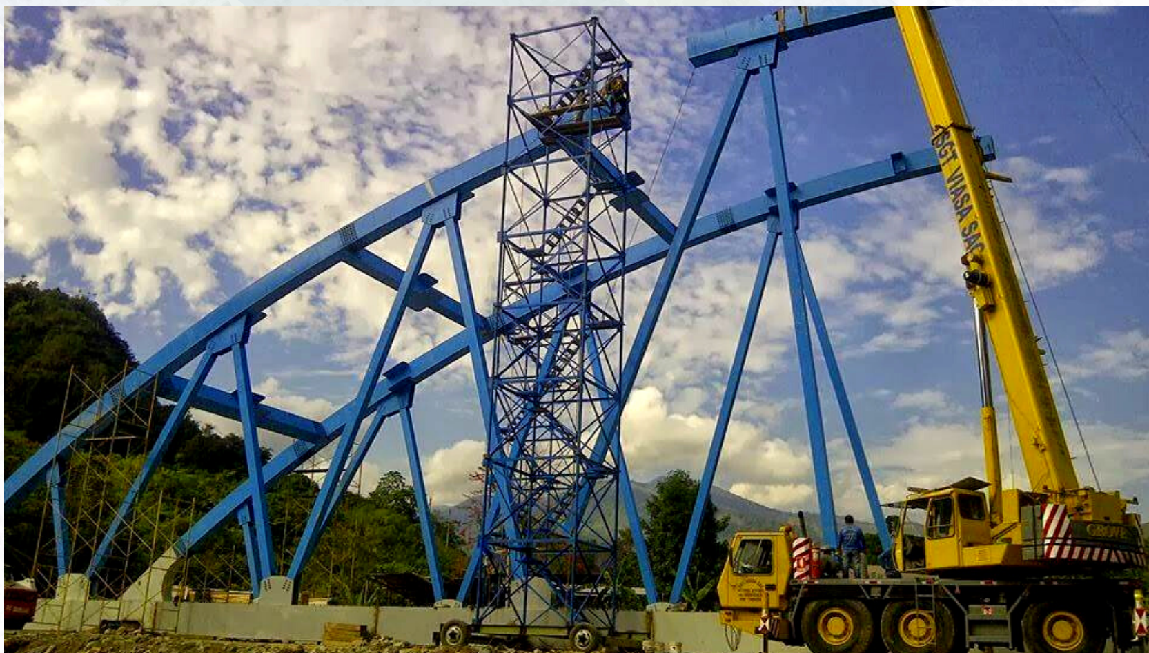
MONTAJE DE PUENTES
