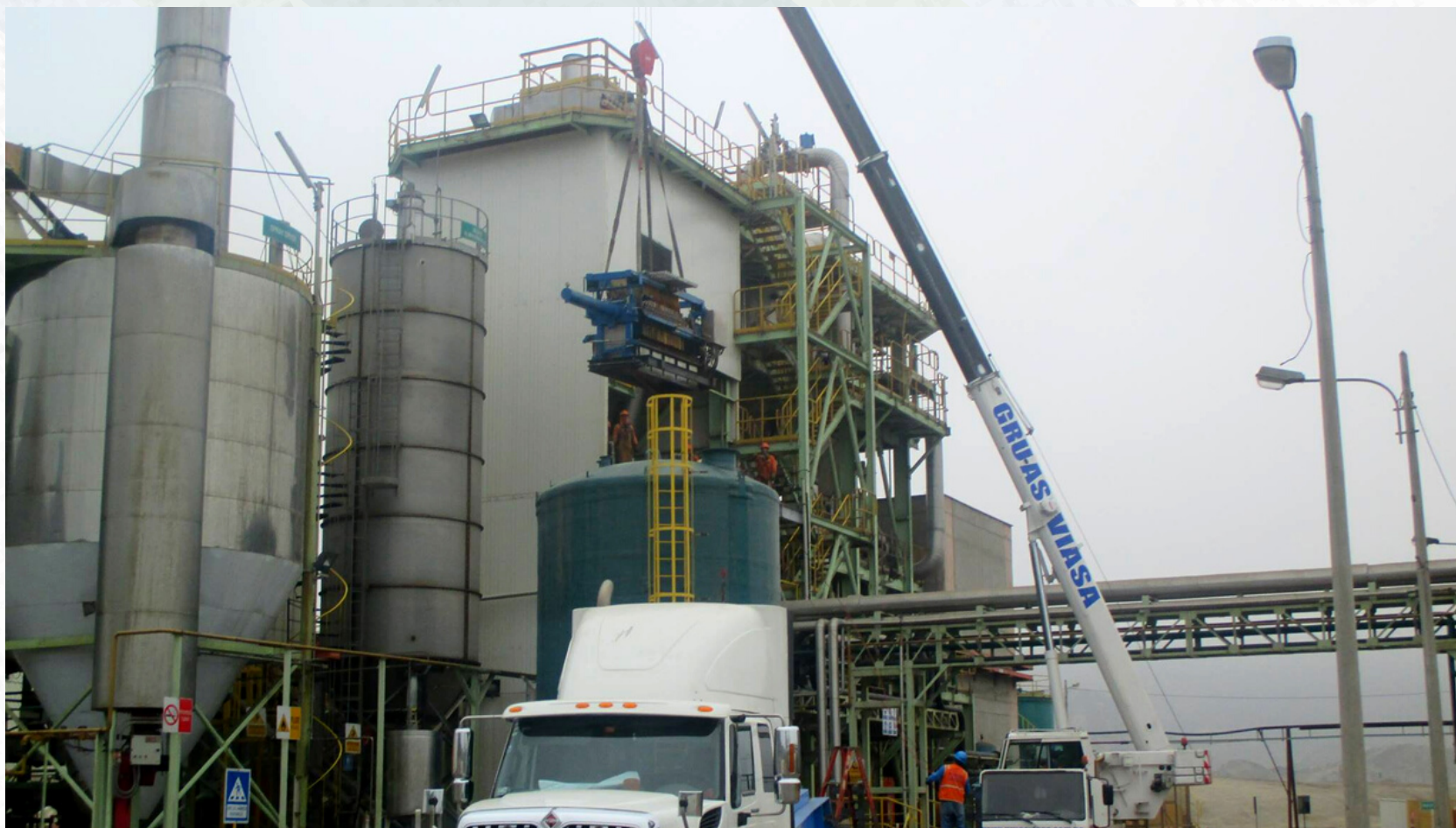
MONTAJE DE EQUIPOS EN EL SECTOR MINERO
