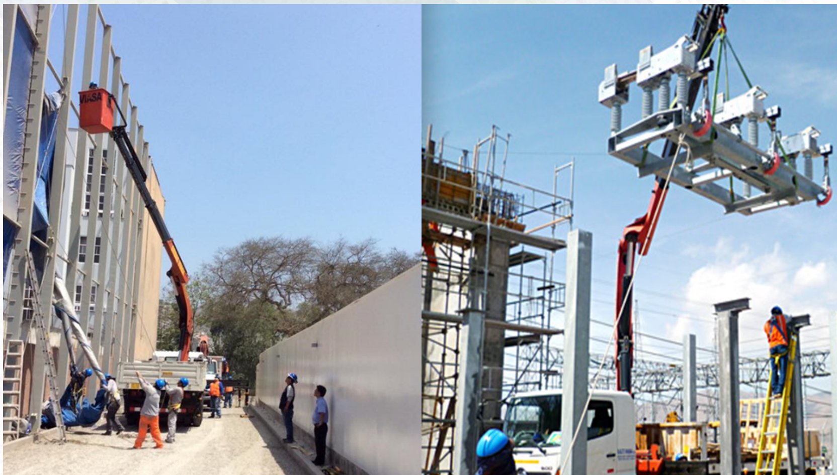
ELEVACIÓN DE PERSONAL Y MANIOBRA DE EQUIPOS
